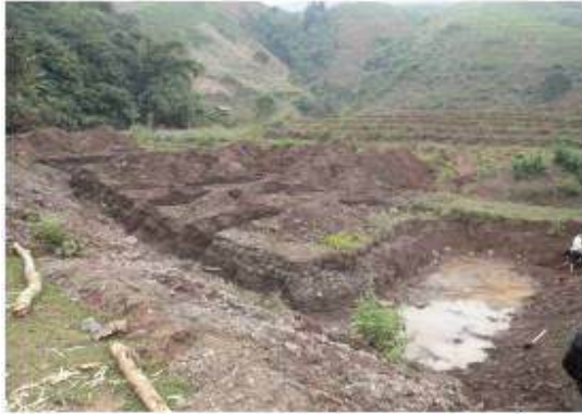
Đào rãnh xương cá để lắp đặt đập ngầm
