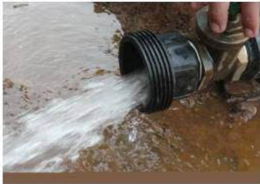
Nước lấy ra sau đập ngầm
