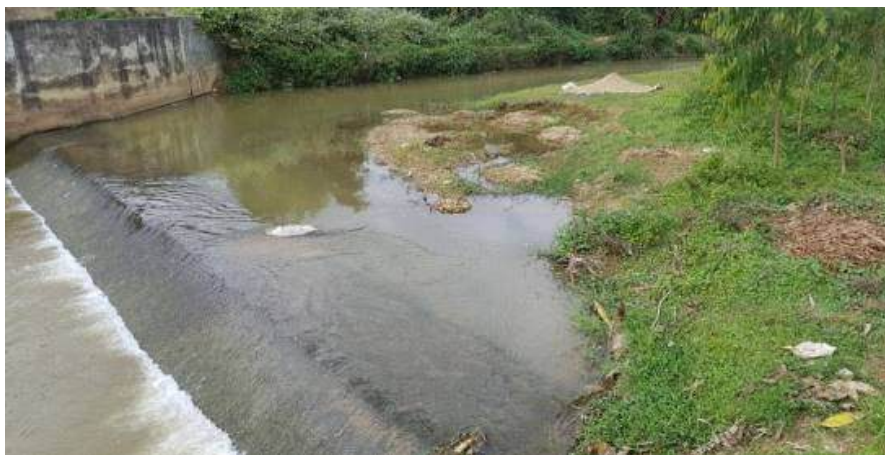
Hình 3.30. Hình ảnh đập dâng cấp nước tại Tuyên Quang
