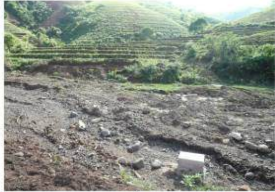
Hoàn trả lại lòng suối sau khi lắp đặt
