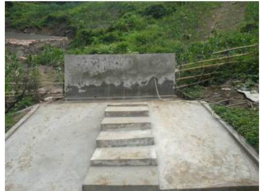
b) Bể chứa nước công cộng hoàn thành
