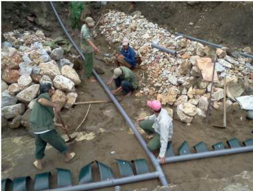
a) Thi công lắp đặt hào thu
